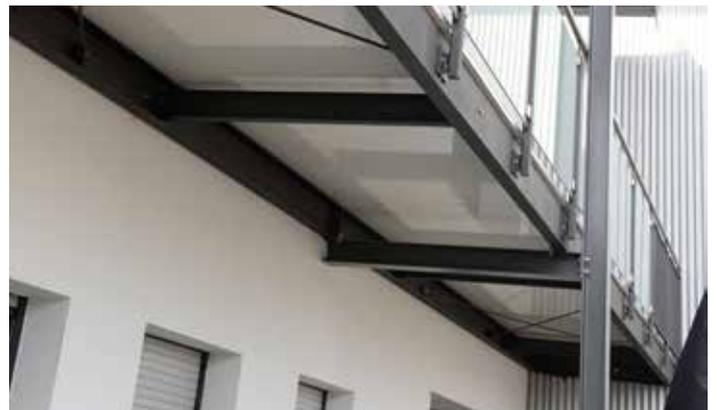
Die TOPERO Balkonbodenpaneele dürfen als lastabtragende Profile als Bodenbelag eingesetzt werden für:
